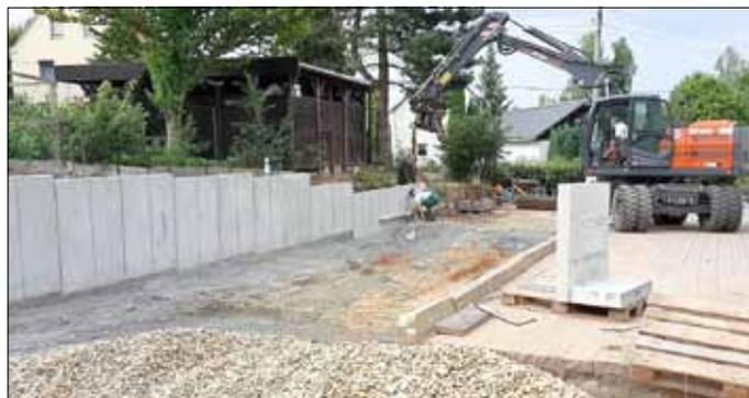
Weiter geht es mit dem Pflastern der Parkflächen und dem Herstellen der Zufahrt zum Gerätehaus. Zeitlich eingetaktet werden die Straßenbauarbeiten in der Kirschallee und die Erneuerung eines Teilabschnitts des Regenwasserkanals vor der Schule im Auftrag des Abwasserzweckverbandes. Bis Ende August sollen die Arbeiten an der Feuerwehr dann abgeschlossen sein.
