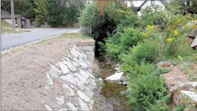
Bereits im August wurde durch die Firma Sebnitztalbau am Cunnersdorfer Dorfbach gegenüber von Hermanns Erben ein 11 Meter langer Abschnitt der Gewässerböschung mittels Steinsatz instandgesetzt.
