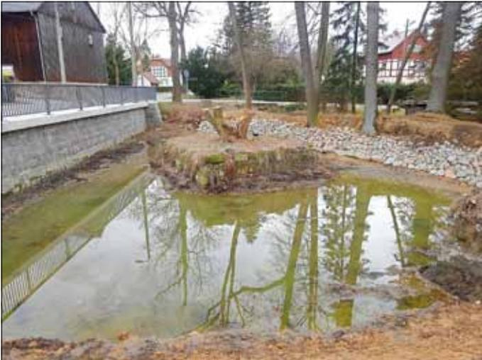
Unsere Bauhofmitarbeiter reparierten im Anschluss die Zuleitung zum Teich, erneuerten die Staubretter im Ablaufbauwerk und verschnitten die Weide auf der Insel. Der Teich ist damit wieder rundherum instand gesetzt und kann wieder angestaut werden. Die Arbeiten konnten relativ unkompliziert ausgeführt werden, da seit der Instandsetzung der straßenseitigen Stützmauer im vergangenen Jahr der Teich trockenlag. Allen Beteiligten ein herzliches Dankeschön für die geleistete Arbeit.
