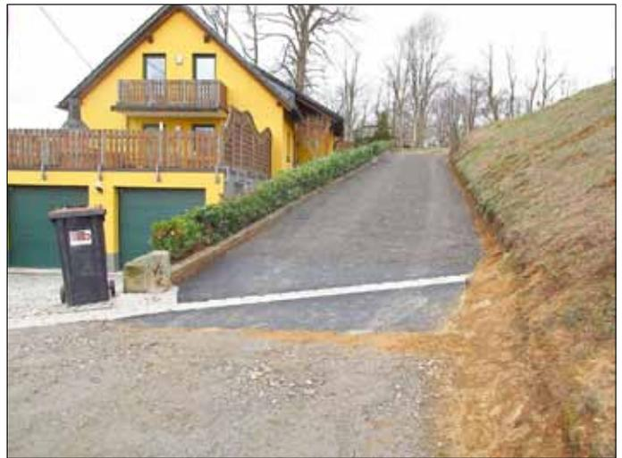
Die provisorische Ablaufrinne in der Straße am Ende des Bergwegs in Hohnstein war im Laufe der vergangenen Jahre fast vollständig zerfahren worden. Die Firma Müller Pflasterbau hat nun die Rinne durch eine sogenannte „Homburger Kante“ ersetzt. Zur Stabilisierung der Rinne wurde in der Straße einen Meter vor und hinter der Kante eine Asphaltenschicht eingebaut. Der stark ausgespülte Bereich der Straße bis etwa zehn Meter oberhalb der Rinne wurde zusätzlich mit einer neuen Deckschicht befestigt.
