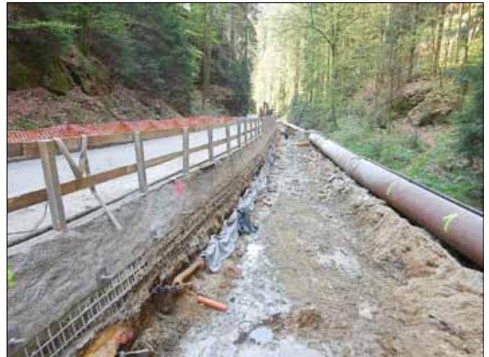
Seit März 2019 wird an der Sense wieder gebaut. Die Firma Kleber-Heisserer aus Dippoldiswalde kommt gut voran. Vorteilhaft ist, dass die Berohrung des Tiefen Grundbaches auf gesamter Länge der Baustelle genehmigt wurde. Damit konnte die marode Straßenmauer auf 200 Metern Länge zurückgebaut werden (Foto). Hier entsteht nun eine neue Betonmauer. Derzeit werden die Bohrpfähle zur Verankerung eingebracht. Die Arbeiten liegen im Zeitplan. So möge es weiter sein.
