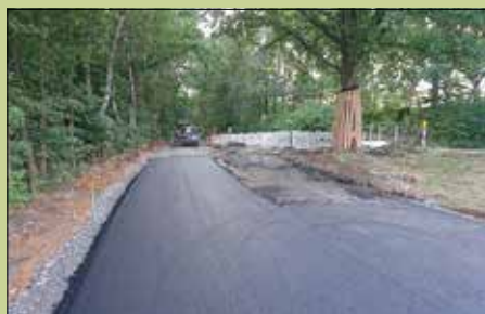
Asphaltierung in Richtung Polenztal.
