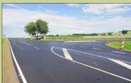
Neue Kreuzung in Richtung Hockstein.
