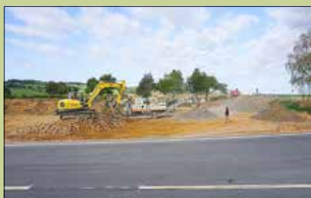
Rückbau der Kreuzung in das Polenztal.
