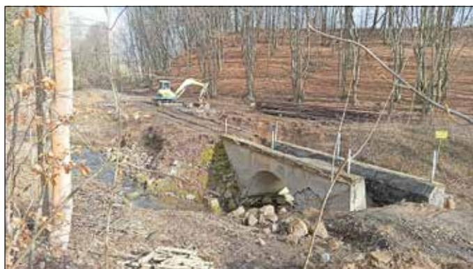
Im Mai wurde an der Brücke wieder fleißig gearbeitet. Die Freilegungsarbeiten sind abgeschlossen. Die Isolation, vermutlich aus Steinkohlenteer, wurde entfernt und zur fachgerechten Entsorgung in einen Container verbracht. Auch mit dem Entfernen der vermeintlichen Putzschicht außen wurde begonnen.
