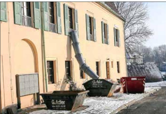
Im März begannen dann die Entkernungsarbeiten im Keller. Die für die Wohnungen eingebauten Wände werden entfernt, um den Zustand aus dem 16. Jahrhundert wieder herzustellen. Und danach soll es im Erdgeschoss weitergehen .....
