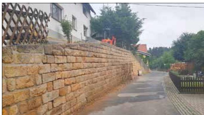
Die Überprüfung der großen Stützmauer an der Bergstraße in Goßdorf ergab dringenden Handlungsbedarf. Das oberste Drittel der massiven Sandsteinmauer verlagerte sich in Richtung Bergstraße. Die Firma Beyer Bau aus Waltersdorf erledigte die Sanierungsarbeiten im Juni und Juli dieses Jahres.
