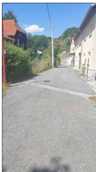
Ende Mai diesen Jahres folgte der Pechhüttenweg mit einer Oberflächeninstandsetzung mit Fräsgut. Das Ergebnis ist gut geworden. In Zusammenarbeit mit dem Bauhof erledigte die Firma Pflasterbau Müller aus Neustadt diese Arbeiten. Rund 14.000 Euro kostete die Instandsetzung, die dringend notwendig war und von den Anwohnern schon lange eingefordert wurde.
