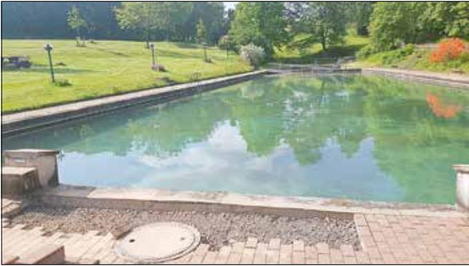
Durch die Zusammenarbeit des Bauhofes mit dem Freibadverein konnte der Abflussbereich des Freibades geöffnet werden, um das Entweichen des Wassers abzustellen. Die Legs konnten gefunden werden, wurden verdichtet und es folgte ein Neuaufbau des Pflasterbereiches. Möge das Wasser im Freibad nun halten. Vielen Dank an alle Beteiligten.
