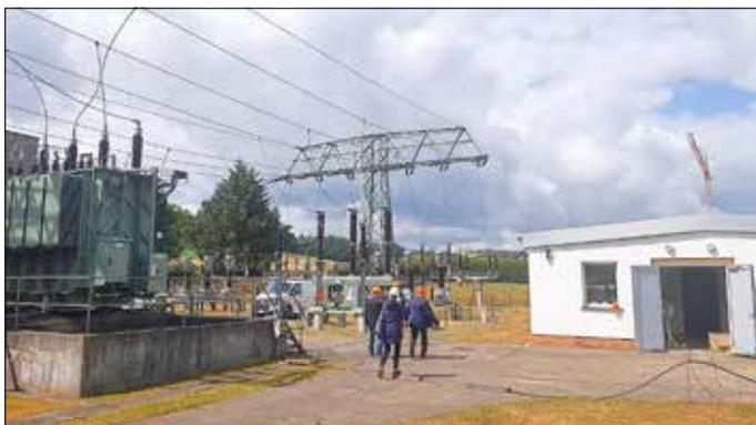
Das alte Umspannwerk wird dann außer Betrieb genommen. Es ist nunmehr 50 Jahre alt und nicht mehr auf dem Stand der Technik. Gerade durch die zunehmende Einspeisung von dezentralen Energiequellen (Fotovoltaik) muss dieser Knotenpunkt im Stromnetz Ost Sachsens dringend ertüchtigt werden.
