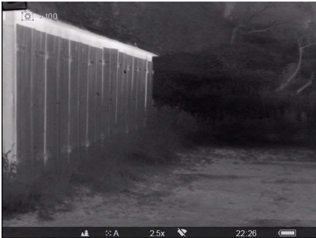
Ansicht Garagen mit Wärmebildkamera
