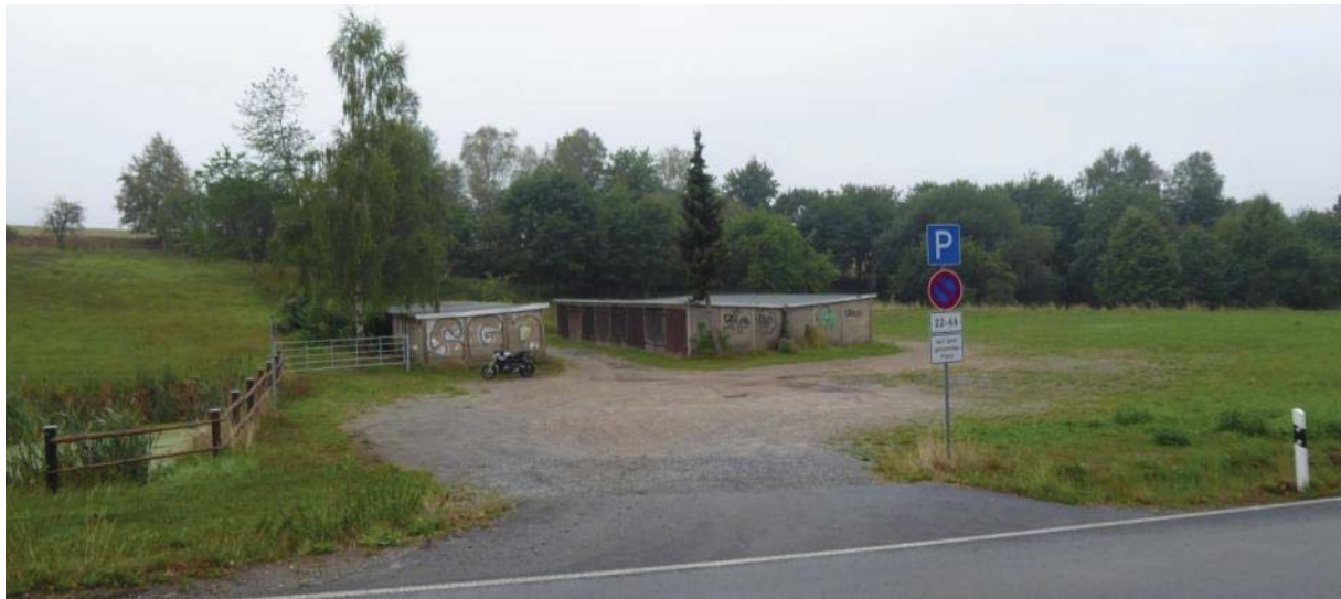
Abbildung 10: Foto Zufahrt, Parkplatz und Garagen (Büro Hübner 08/2022)
