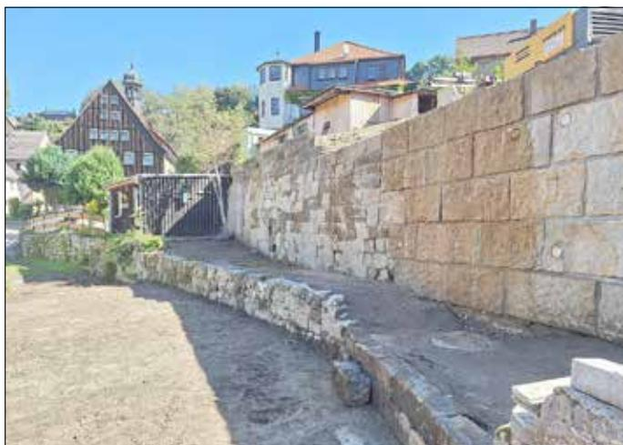
Aktuell ist die Mauer an der Giebelseite des Rathauses zurückgebaut und wird nach Neuverlegung der angetroffenen defekten Entwässerungsleitungen wieder neu aufgebaut (siehe zweites Foto). Abschließend soll dann bis Mitte September der vordere Abschnitt der Rathausmauer neu aufgesetzt werden.
