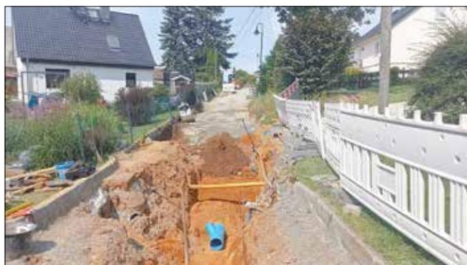
Beim grundhaften Ausbau der Brandstraße-Siedlung ist im oberen Bauabschnitt die Verlegung des Straßenentwässerungskanal und der Trinkwasserleitung weitestgehend abgeschlossen. Die Strabag Gruppe Dippoldiswalde führt die Bauarbeiten durch. In der kommenden Woche beginnt der Einbau der Winkelstützelemente am Grundstück Deutscher. Im Zuge des weiteren Straßenbaus werden dann noch die Leerrohre für den Breitbandausbau verlegt sowie die Energie- und Straßenbeleuchtungskabel erneuert.
