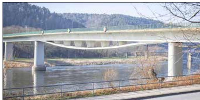
Der Belastungstest in der ersten Aprilwoche war erfolgreich. Mit 320 Tonnen Belastung und einer Sensorenmessung konnten keine Schädigungen der Brücke festgestellt werden. Die Brückenprüfer gaben daraufhin grünes Licht für eine eingeschränkte Freigabe der Bad Schandauer Elbbrücke. Die Brücke ist seit dem 10. April für Fahrzeuge bis zu 7,5 Tonnen, Fußgänger und Radfahrer wieder nutzbar. Lkw und Busse werden weiterhin über die Umleitungsstrecken fahren müssen.
