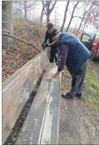
Frühjahrsputz in Ulbersdorf mit Ausbesserungsarbeiten an der langen Bank am Krumhermsdorfer Berg
